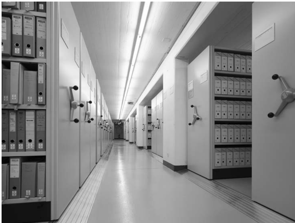
Blick auf die neu installierten Rollgestelle im 4. Untergeschoss (Foto: Andreas Frutig)
